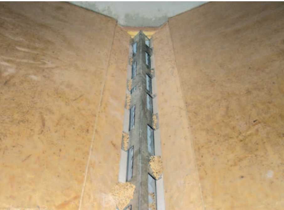
Transportorul elicoidal HDG, conduce peletii din spațiile de depozitare.
