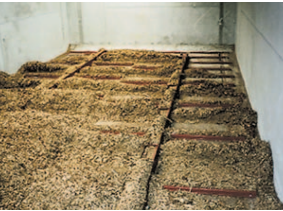
Sistemul HDG de livrare cu tavă glisantă este adesea folosit la sistemele de încălzire mai mari. Prezintă cea mai mare capacitate de încărcare.
