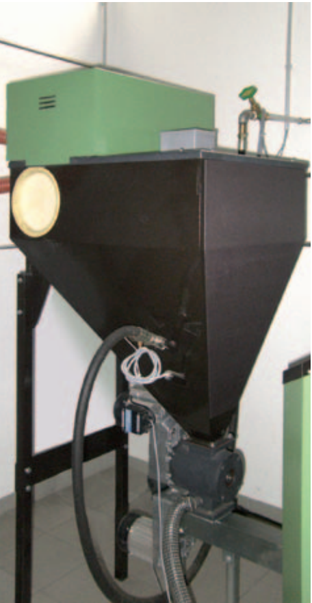
Containerul intermediar al sistemului HDG de aspirație a peleților poate prelua până la 100 Kg. Această cantitate este suficientă pentru ca HDG Compact 50 să funcționeze peste 8 ore fără întrerupere.
